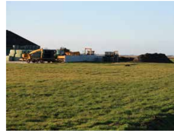
Plaats opslag en apparaten niet 'kaal' in de ruimte: zorg voor een duidelijk gemarkeerd erf.
