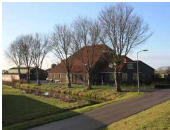
Mijzerdijk 6 vanuit oost
