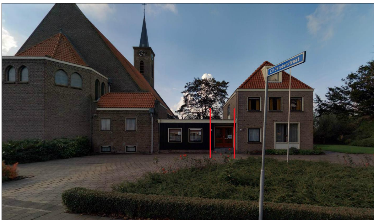
Te slopen gedeelte laagbouw (tussen de rode lijnen)
