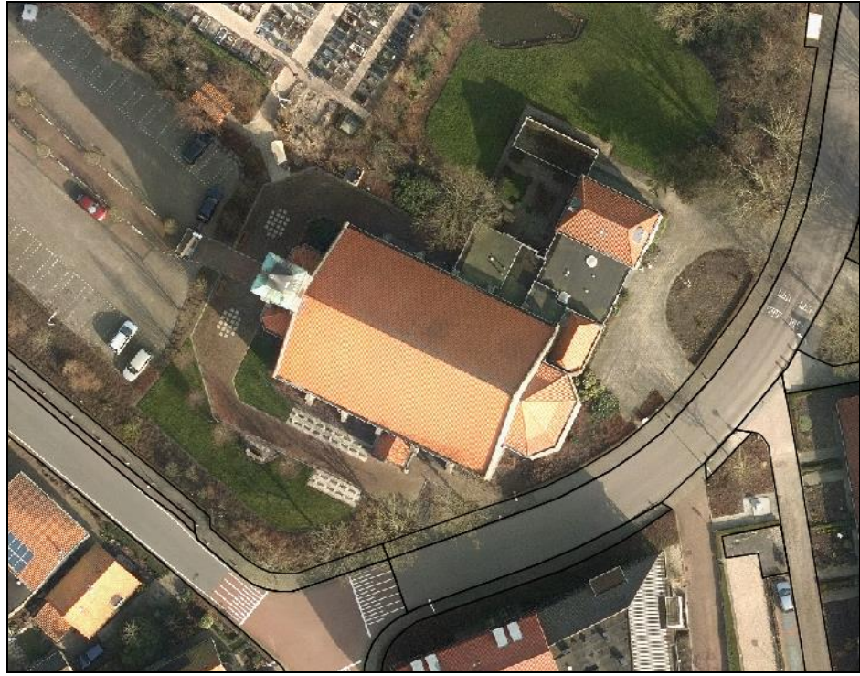
Luchtfoto Noorddijkerweg 1a
