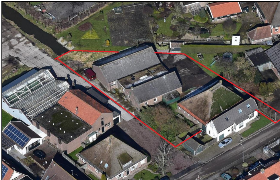
Plangebied met rode contour aangegeven. Het witte voorhuis valt buiten het plangebied
