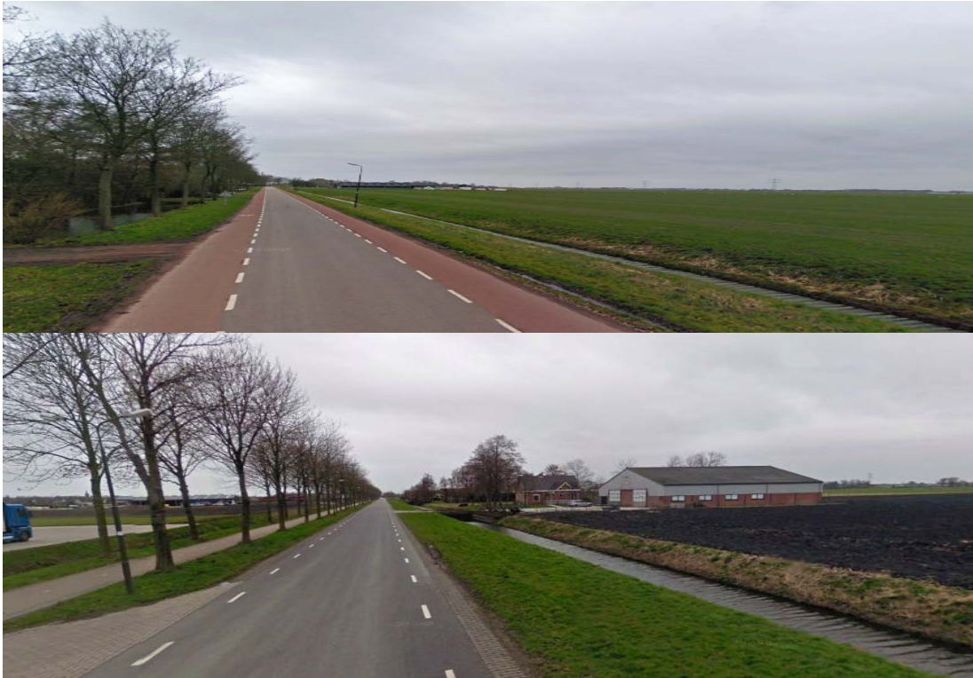
Figuur 6: Erftoegangsweg buiten de bebouwde kom type 1 (boven Noordijkerweg, onder De Leet).
