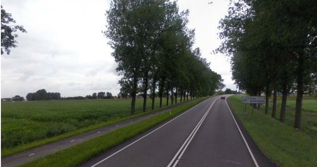
Figuur 3: Gebiedsontsluiting buiten de bebouwde kom (N243).
